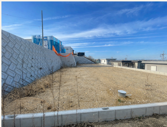
現地から北側を撮影
